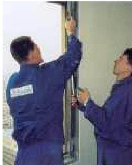
◀ Foto 4. Fijación definitiva. Además de los métodos de fijación antes mencionados, para darle más solidez, rellenaremos los espacios vacíos entre el marco y la pared con espuma de poliuretano. Para ello humidificaremos el marco con un vaporizador para que se adhiera y se expanda más la espuma. También usamos cintas que se expanden hasta 30 mm. entre el hueco de la pared y el marco de la ventana. Así se queda estanca.
