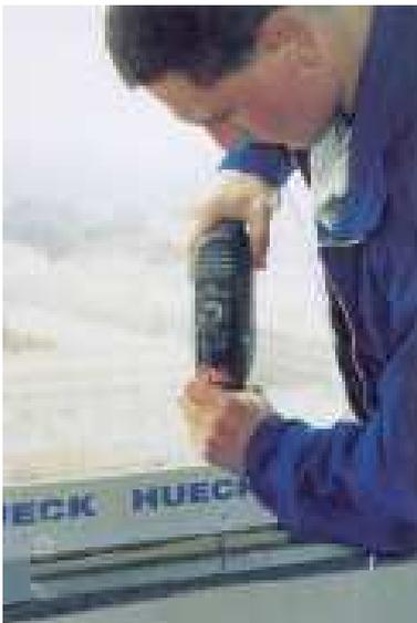
▲ Foto 3. La fijación de las patas. Las patas de sellado las fijaremos con los tornillos y tacos. Se basa en que el tornillo está colocado dentro de una tuerca y se prolonga por una pieza cónica que se ensancha cuando la atornillamos.
