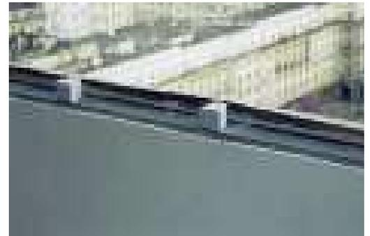
▶ Foto 2. Las cuñas. Para que la ventana nos quede totalmente horizontal y con un espacio regular entre el marco y la pared, colocaremos transversalmente unas cuñas de madera o de perfil PVC sobre las que asentaremos la ventana..
